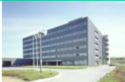
神戸コンピュータセンター
