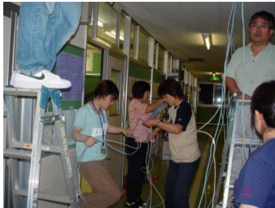
廊下天井裏通線の様子
