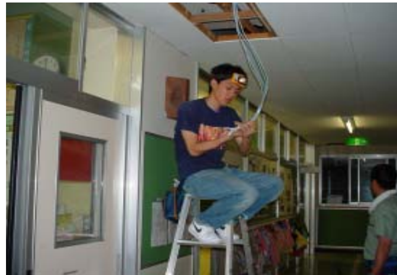
廊下の天井裏を通線・末端部の引き出し
