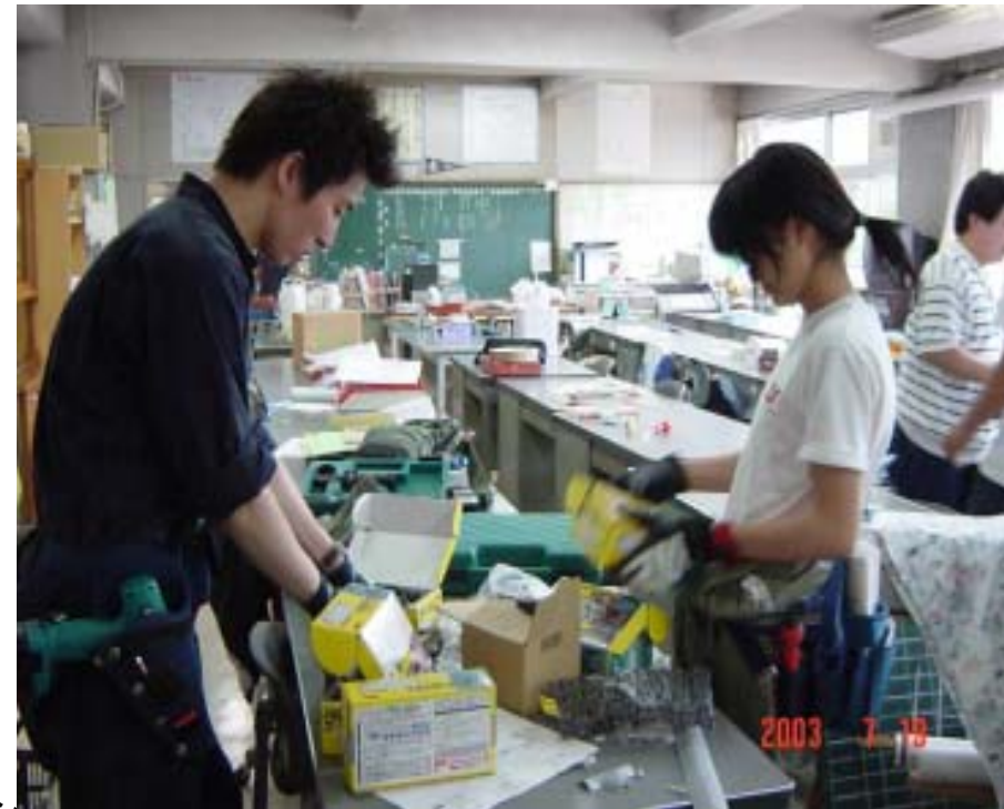
職員室内の配線工事
