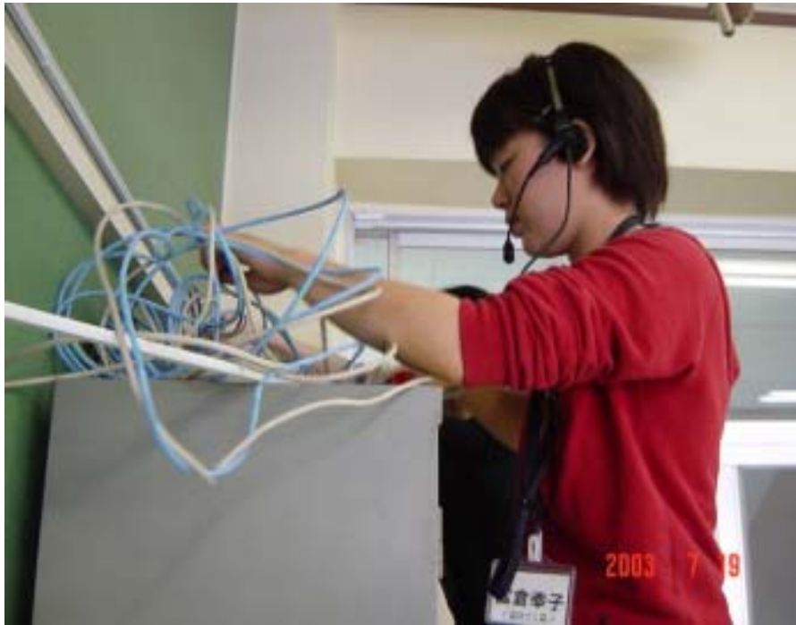
教室内の配線工事
