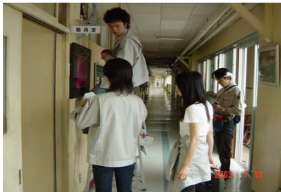
職員室へのケーブル引き込み
