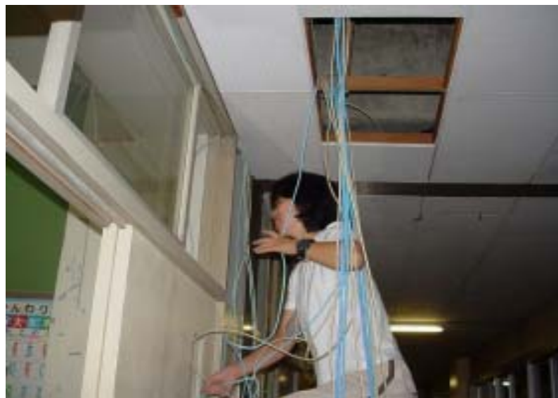
天井裏通線風景
