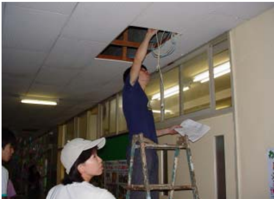
廊下の天井裏を通線・末端部の引き出し
