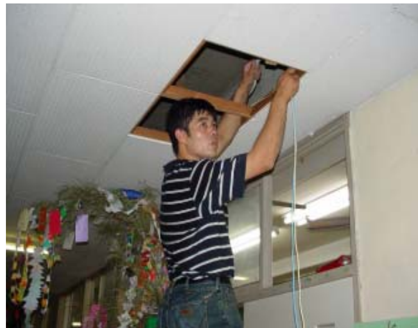
末端部の引き出して、教室内へ伸ばす
