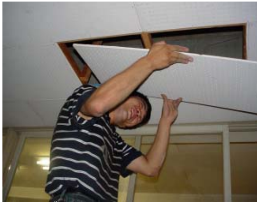
天井裏通線後は空けた蓋を閉める
