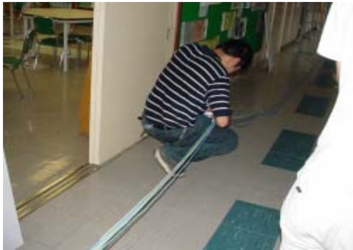
UTPケーブルの束の敷設準備
