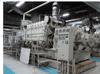
データセンターに設置された自家発電機
