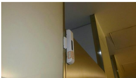
トイレのドアにセンサーを設置
