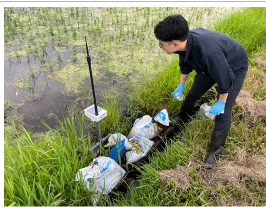
圃場に自動給水ゲートを設置する様子
