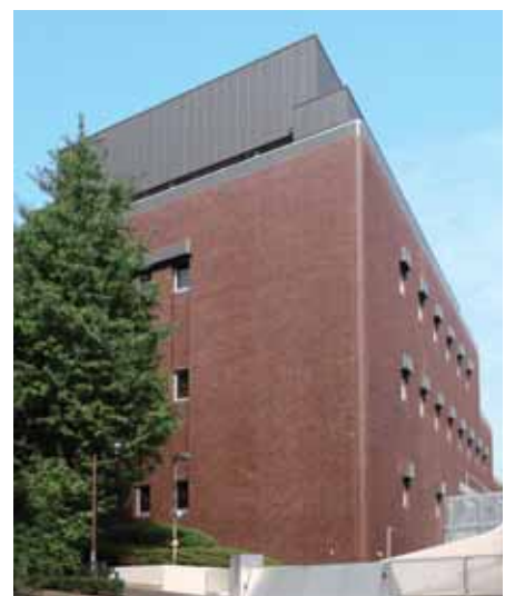
環境配慮型データセンター「目白坂データセンター」
